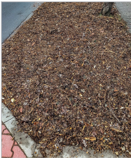
Część pasa drogowego, wypełniona wysokochłoną warstwą zrębków
