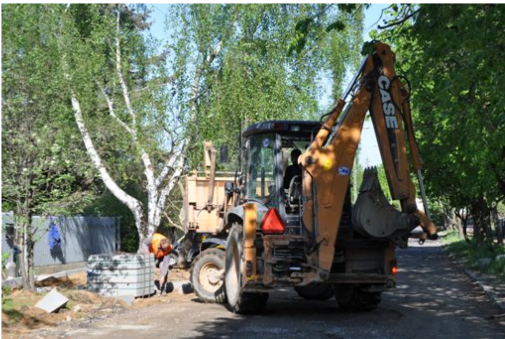
Przebudowa ul. Szczęśliwej wraz z budową chodnika i odwodnienia
