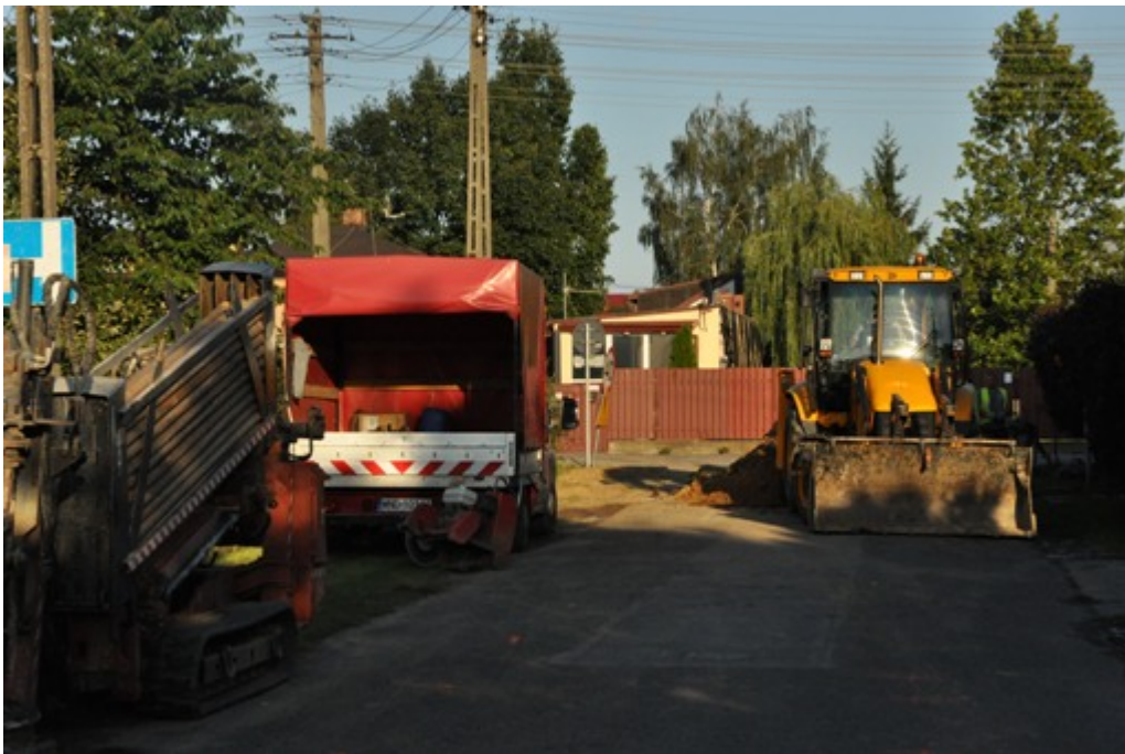
Remont śluzy (wał przeciwpowodziowy - Jezioro Dziekanowskie)
