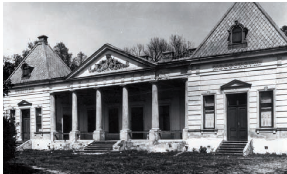
Widok frontu pałacu w 1916 r.
