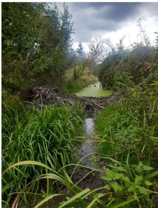
Fot. 24 (po lewej). Widok na koryto ciekuj z tamą bobrową oraz piętrzeniem.
