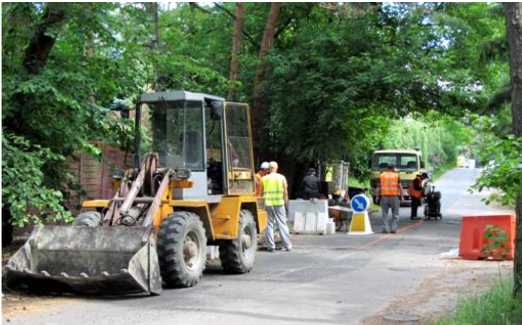
▶ Rozbudowa oczyszczalni ścieków
