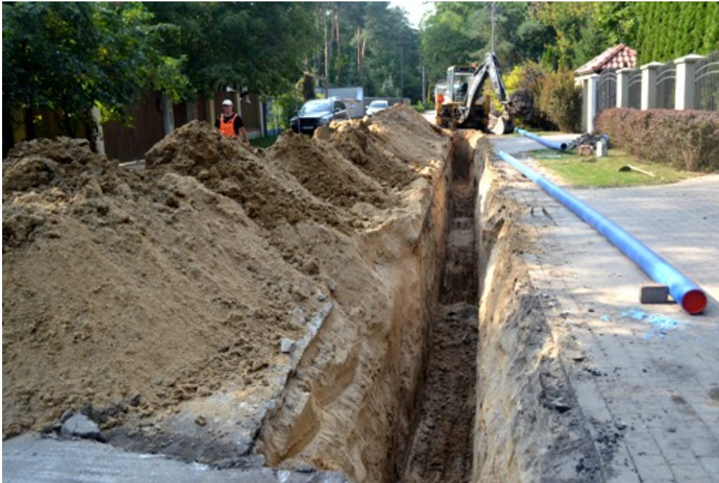
▷ ul. Długa (inwestycja wodno-kanalizacyjna)
