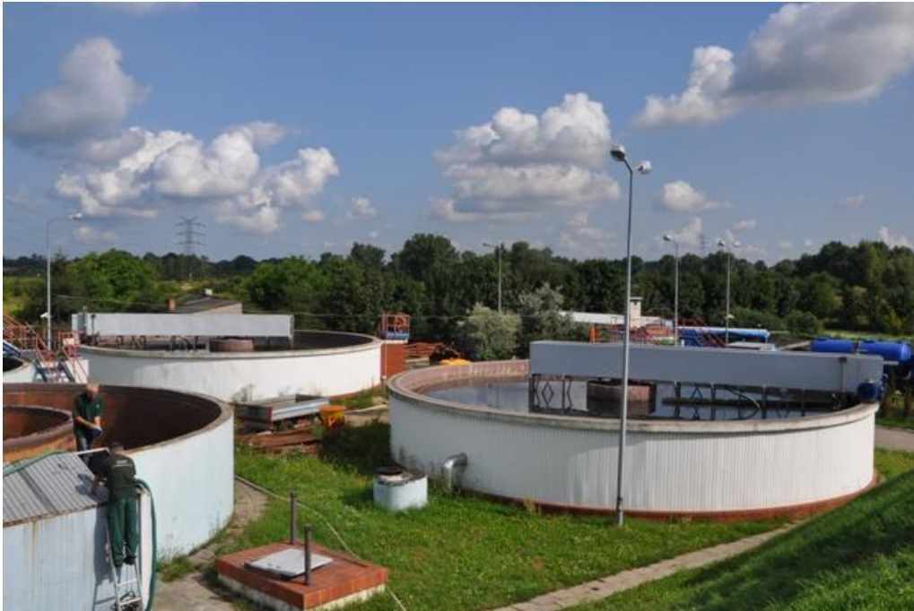
Oczyszczalnia ścieków w Łomiankach
