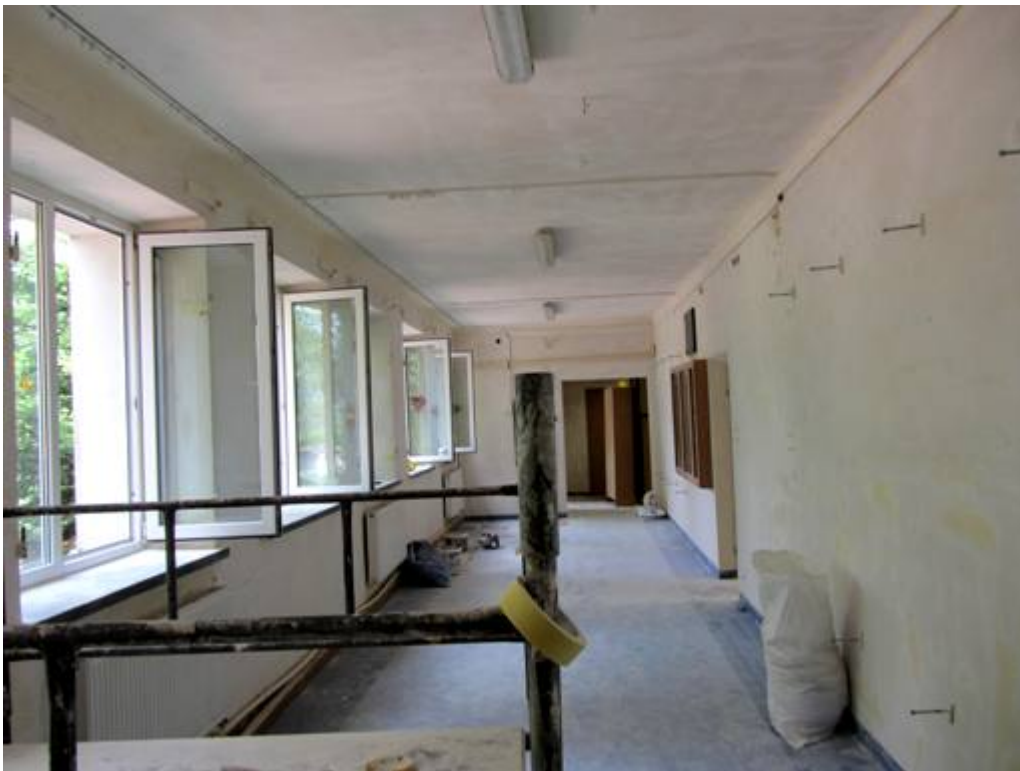
Na zdjęciu przygotowanie powierzchni ścian do malowania w szkole w Sadowej
