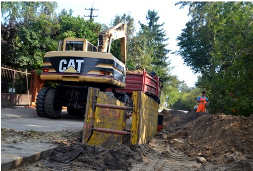
▷ ul. Partyzantów (uporządkowywany jest teren pod nową szkołą podstawową w Dąbrowie Leśnej, po budynkach przeznaczonych do rozbiórki nie ma już śladu)
