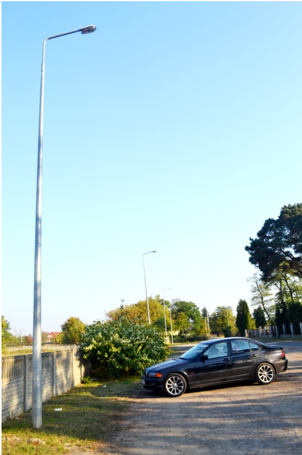
▶ ul. Pogodna (wykonano prace związane z udrożnieniem komunikacji w ciągu ul. Pogodnej)
